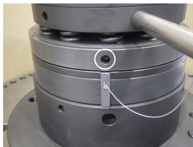
復帰操作が完了した状態 写11
