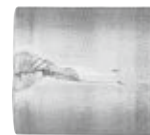
図43. ローラのクラック
